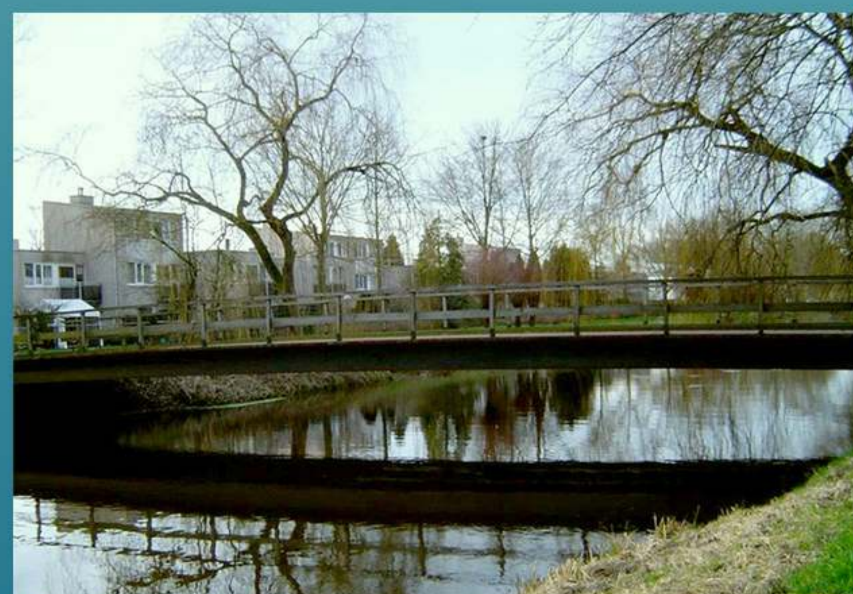
Dit is fiets-voetgangersbrug 't Werdje over het afwateringskanaal nabij de sluis in Gestel (Hanevoet 2007).
