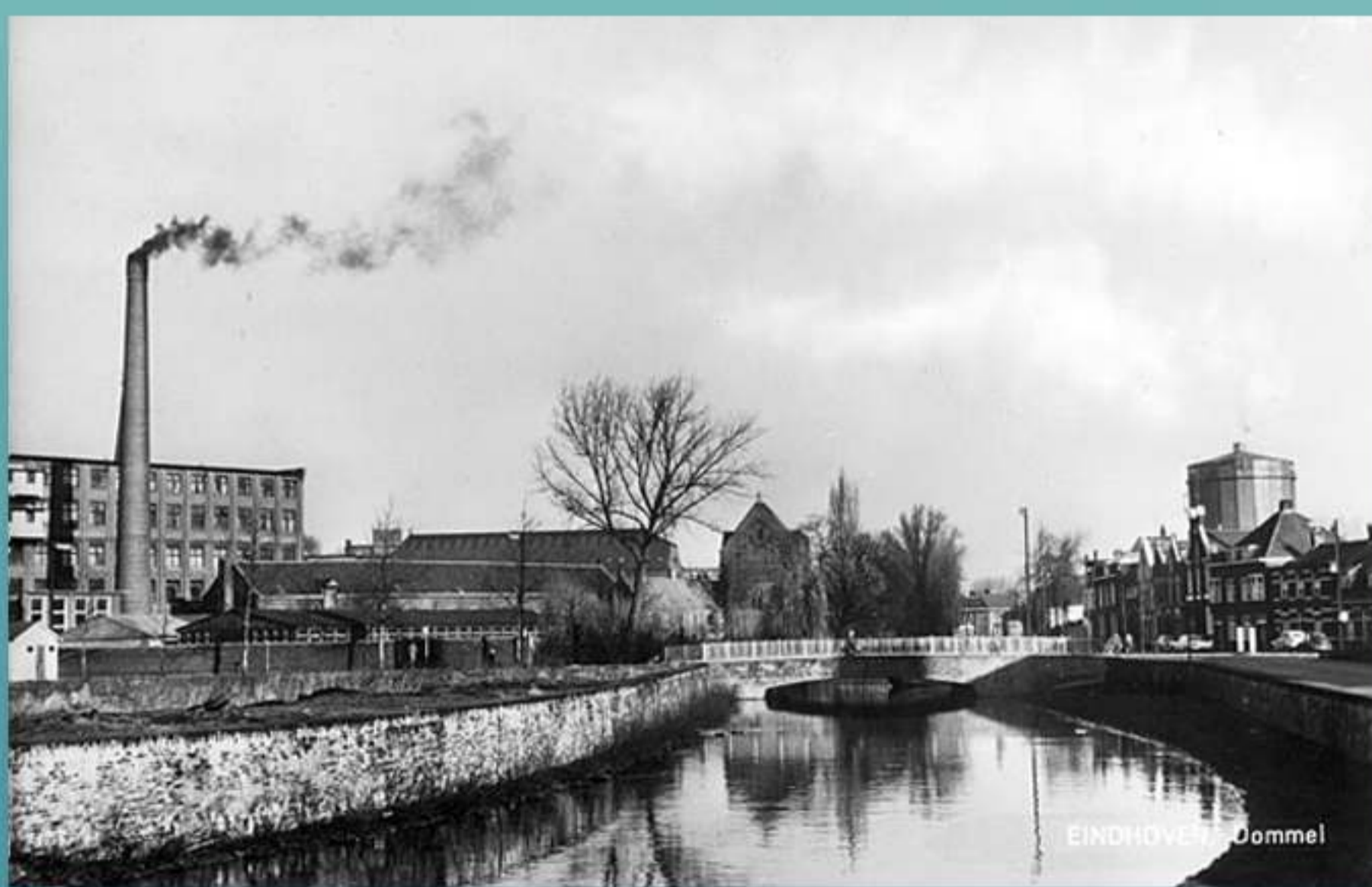
Fraai zicht over de Dommel met rechts de gashouder.
