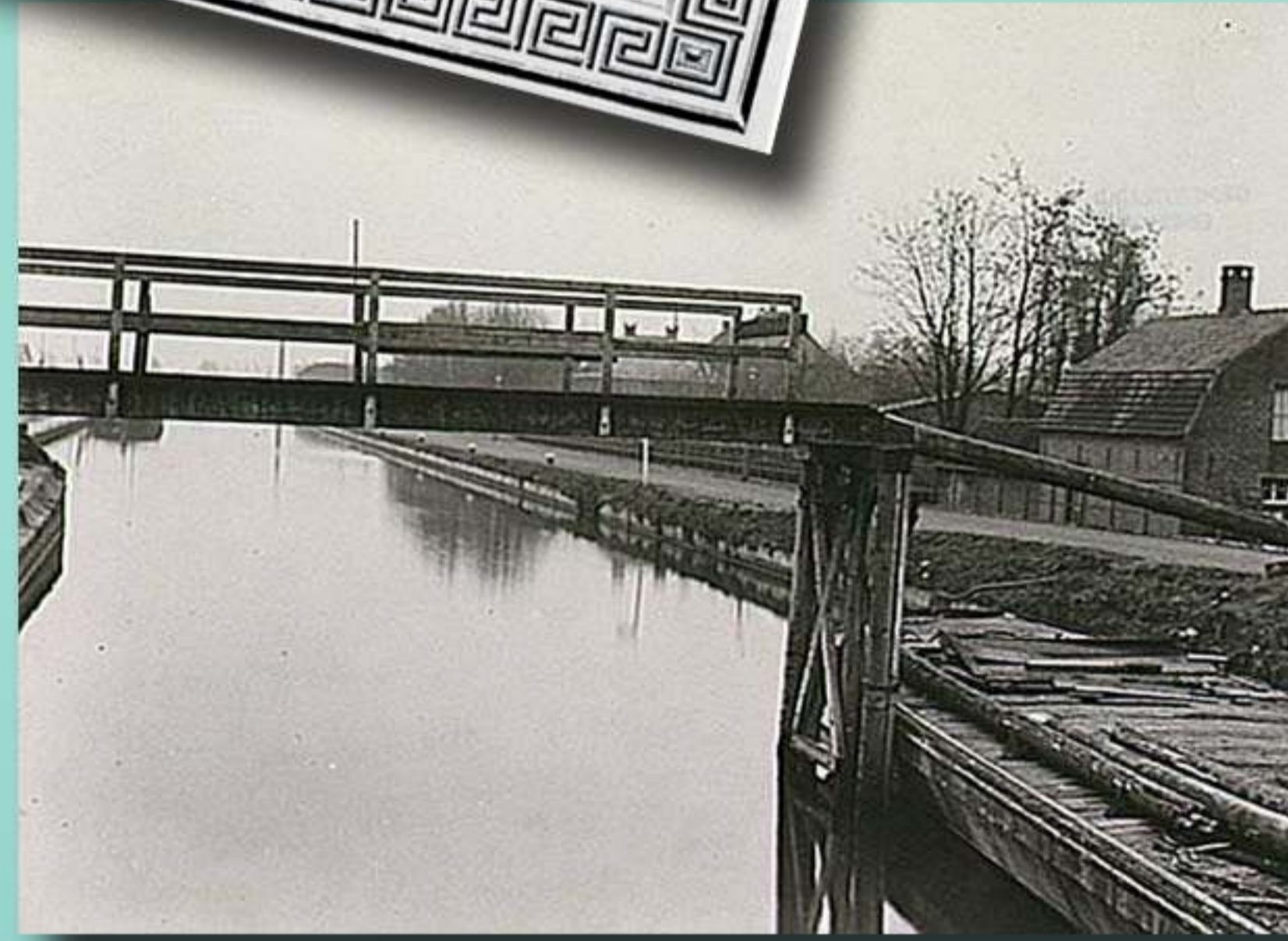
Deze foto is genomen vanaf de nieuwe hefbrug ofwel in de volksmond de "eerste brug". Wat we hier zien zijn de overblijfselen van de oude brug die voor de bouw van de nieuwe hefbrug al gedeeltelijk afgebroken was.
