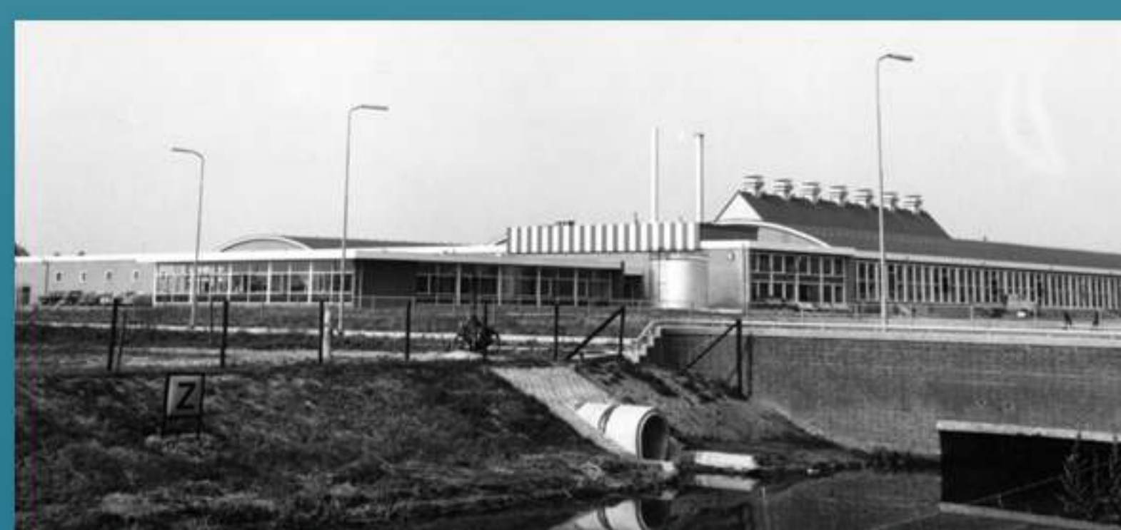
Bouw nieuwe spinnerij Van Moorsel aan de Beemdstraat (later magazijnen van de Etos-bakkerij).
