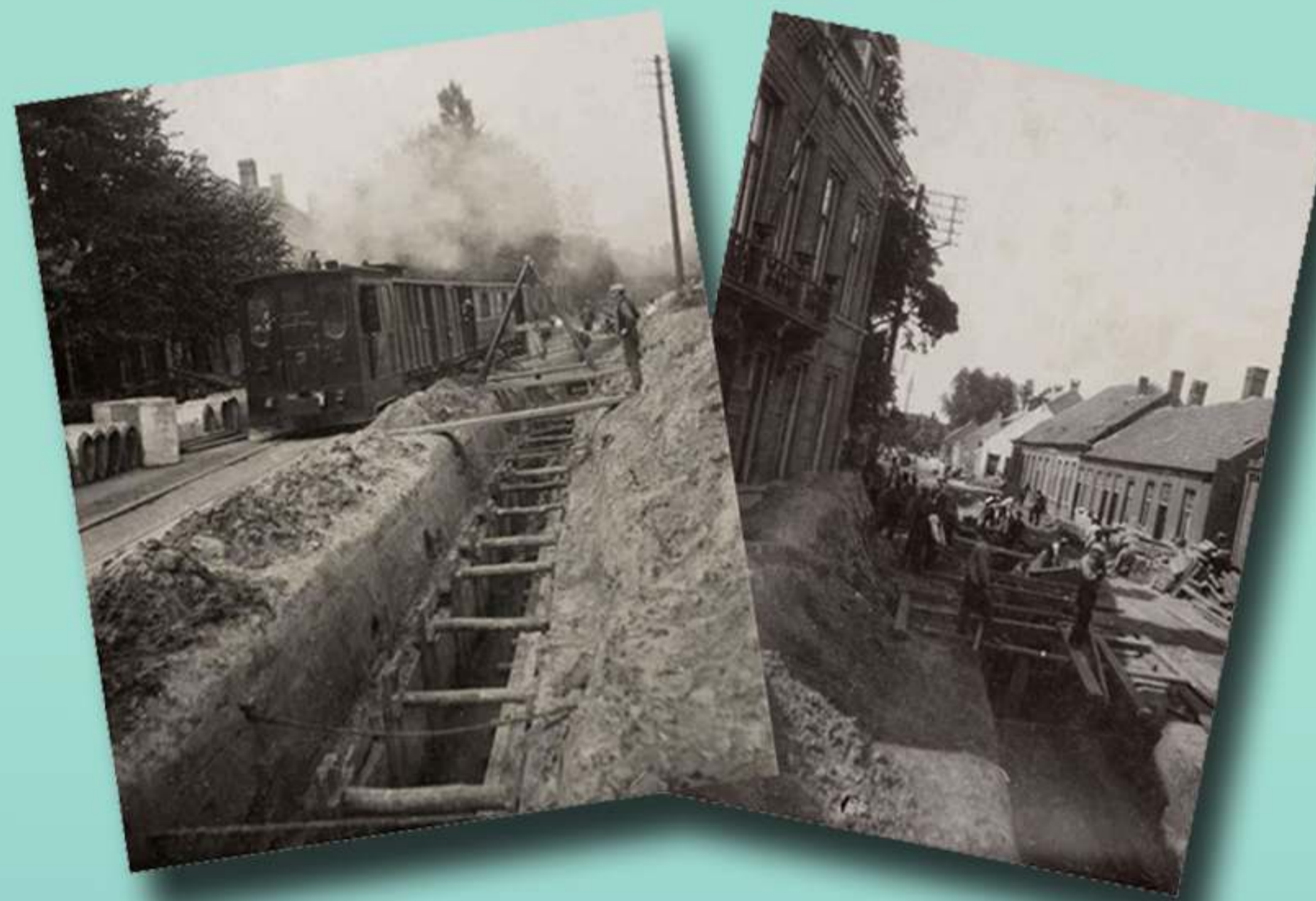
De foto's zijn gemaakt tijdens de aanleg van de riolering in 1935. Rechterfoto is ongeveer ter hoogte van Hoogstraat 250. Hier passeert zojuist de stoomtram naar Reusel. Op de linkerfoto zie je hoe weinig ruimte er voor de stoomtram overbleef. Links de villa van Kerssemakers. We bevinden ons dus ongeveer op het kruispunt Hoogstraat/Boutenslaan.
