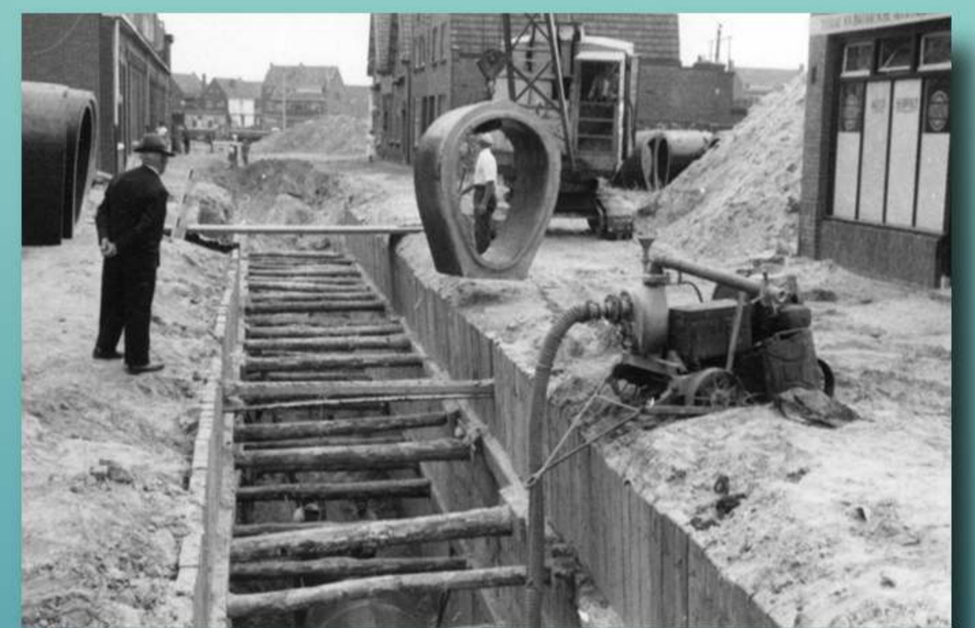
Rioleringswerkzaamheden op de Harmoniestraat.
