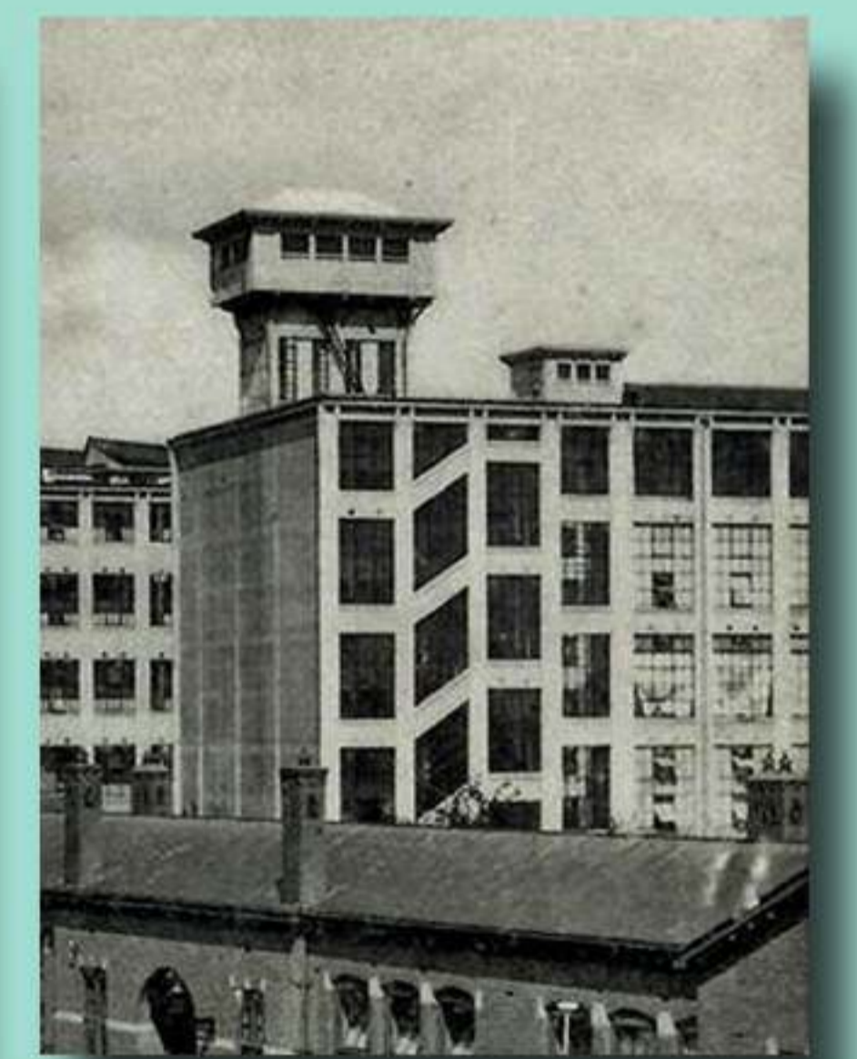
Deze toren, van voor 1911, is de watertoren van Philips, dat zeker tot midden jaren twintig zelf water oppompte dat in deze toren werd opgeslagen. Door de hoogte van de toren stak hij boven de fabriek uit en kon men ook druk op het leidingnet van Philips opbouwen. Het schijnt zelfs dat Philips in de piekuren het waterleidingbedrijf van Eindhoven bijspong omdat zij niet voldoende capaciteit hadden.
