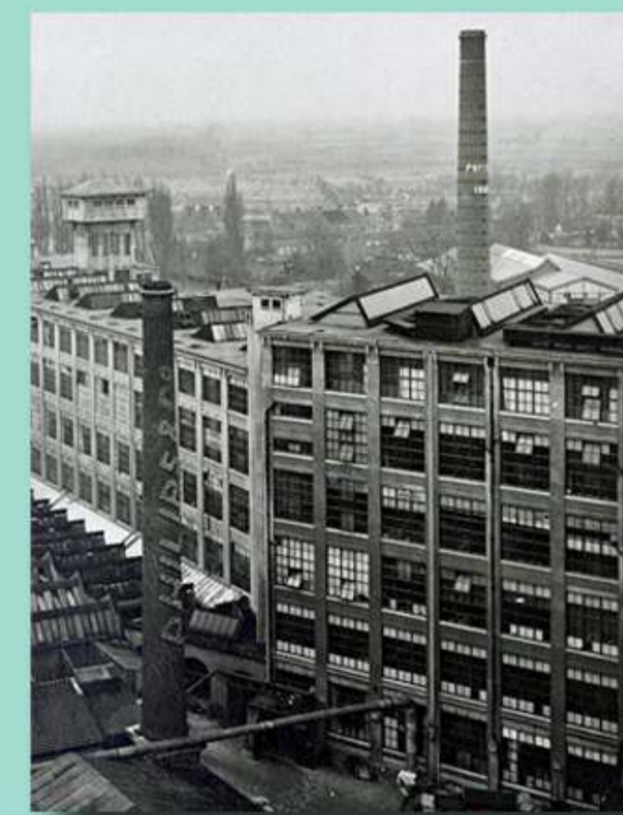
Deze toren, van voor 1911, is de watertoren van Philips, dat zeker tot midden jaren twintig zelf water oppompte dat in deze toren werd opgeslagen. Door de hoogte van de toren stak hij boven de fabriek uit en kon men ook druk op het leidingnet van Philips opbouwen. Het schijnt zelfs dat Philips in de piekuren het waterleidingbedrijf van Eindhoven bijspong omdat zij niet voldoende capaciteit hadden.
