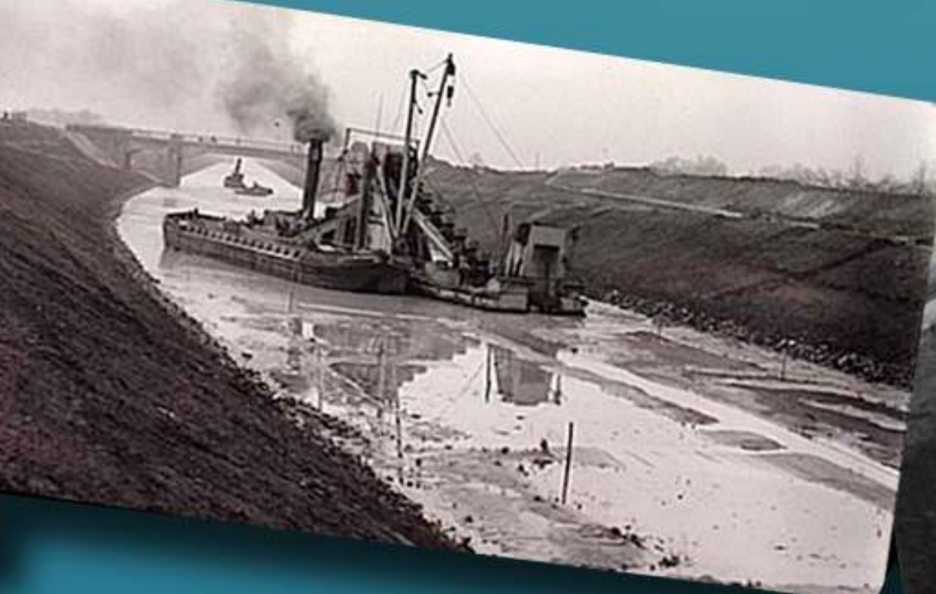
Het graven van het Beatrixkanaal gebeurde meest machinaal, eerst met twee imposante graafmachines en daarna met deze baggerschuit.
