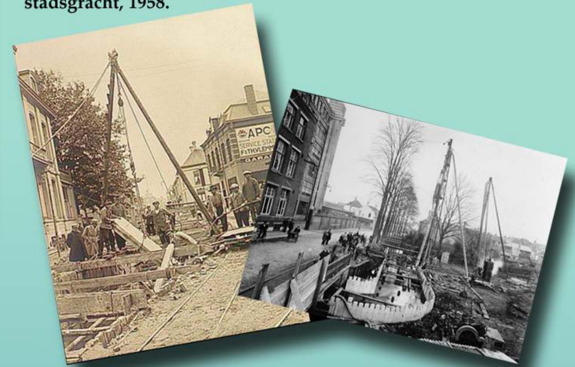
Op de linkse foto de overkluizing van de Stadsgracht en de aanleg van een afvoerring. We kijken vanaf het Stationsplein richting Nieuwstraat. Op de rechtse foto de overkluizing van de Gender op de Emmasingel in 1925.
