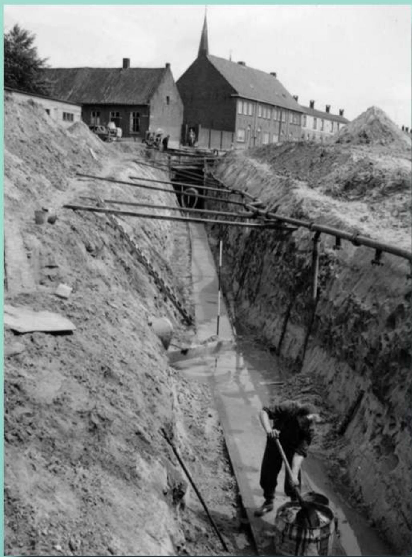
Aanleg riolering in de Harmoniestraat. De huisjes links staan in de Lijmbeekstraat.
