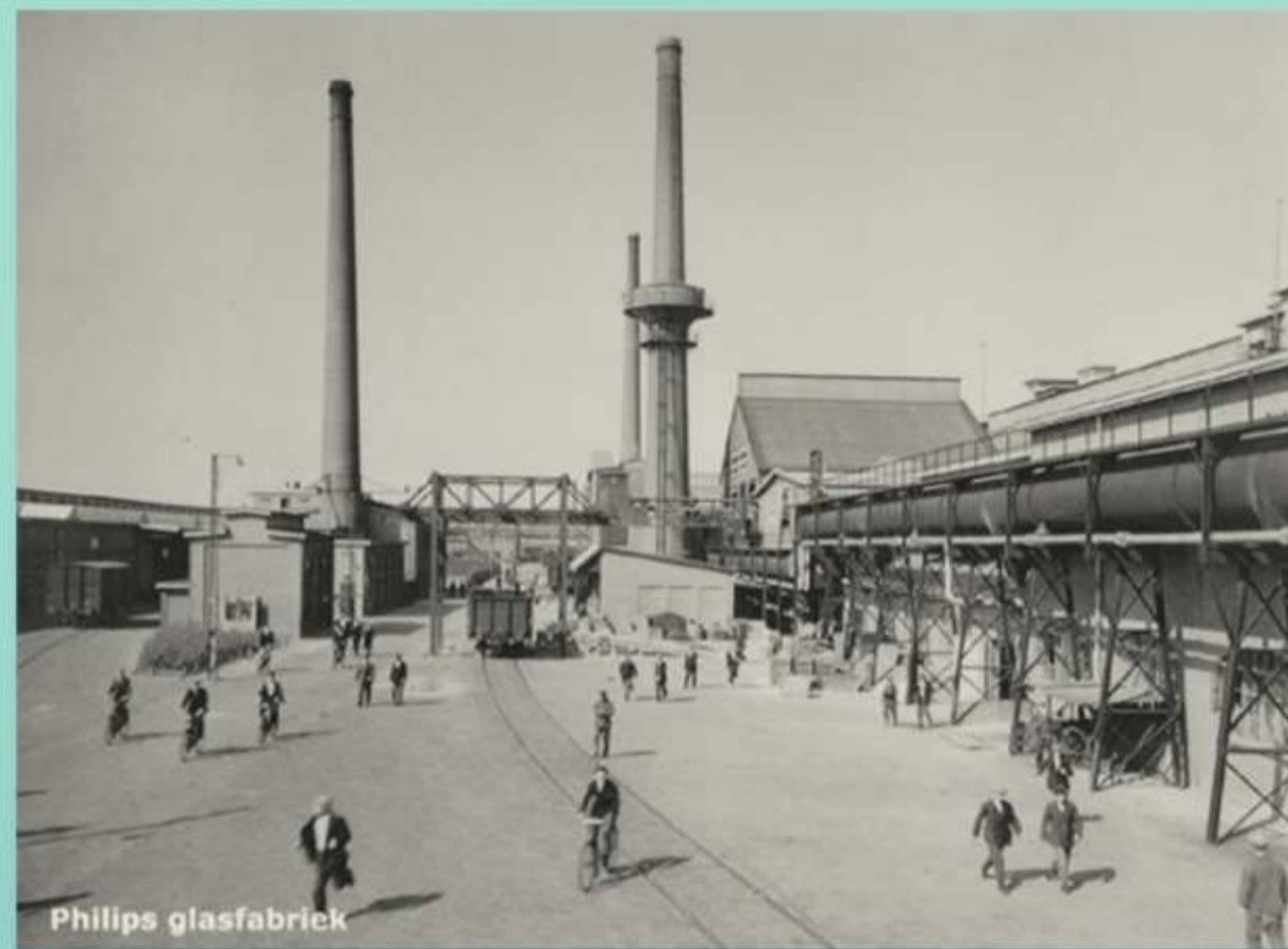
Een foto van een schoorsteenwatertoren. Het bouwsel stond op het Philips fabriekscomplex Strijp S en stamt uit 1917, toen daar de glasfabriek uit 1915 werd uitgebreid.
