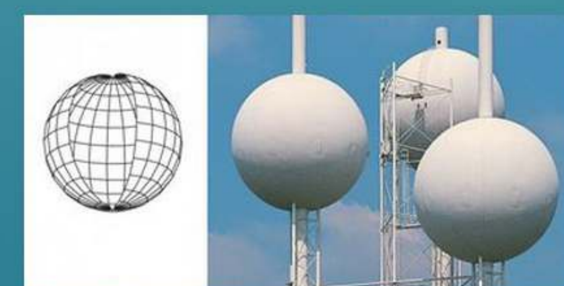
Kogelreservoir. Theoretisch is de bolvorm ideaal voor een gesloten reservoir. De bol heeft immers de grootste inhoud bij het kleinste oppervlak. De ondersteuning is echter gecompliceerd en daardoor kostbaar. Hier is de draagconstructie deels in het reservoir aangebracht.
