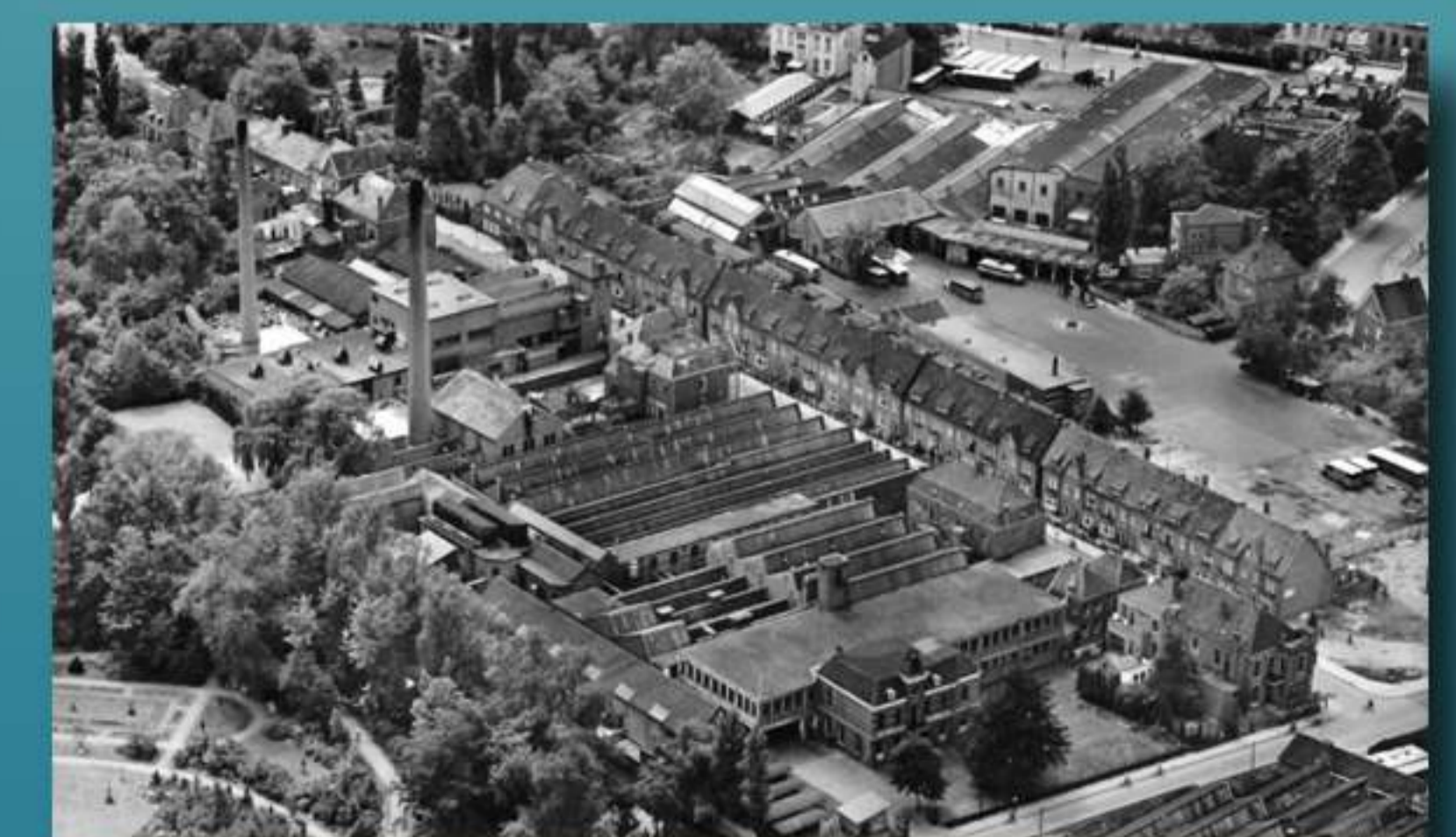
Textielabriek de Haes aan de Tramstraat. Linksonder in de hoek een stukje van de prachtig aangelegde tuin van huize De Laak, de woning van Anton Philips. De Tramstraat met de rij woningen die gebouwd zijn nadat de Tramremise daar is gesloopt na 1936.
