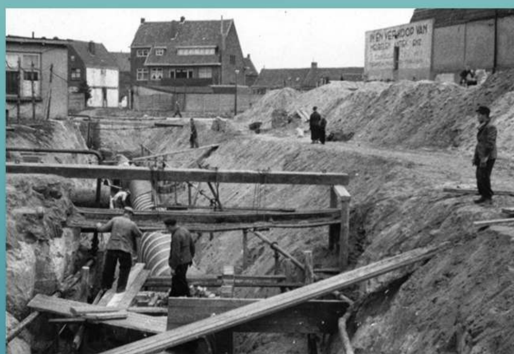
Rioleringswerkzaamheden op de verlengde Harmoniestraat.
